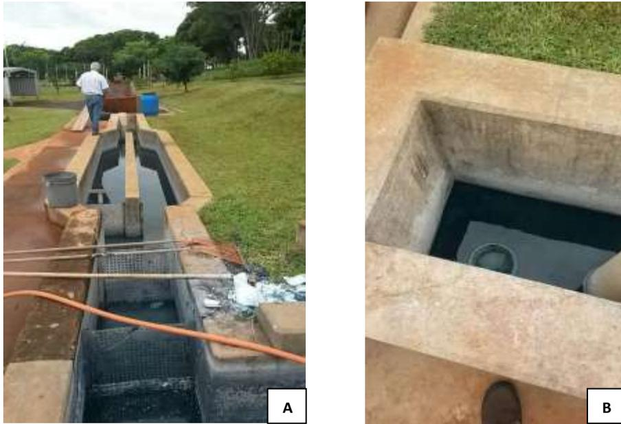
**Figura 4.** Grade coletora que separa os sólidos grosseiros (A), comportas de acesso para os tanques de Flotação(B).
