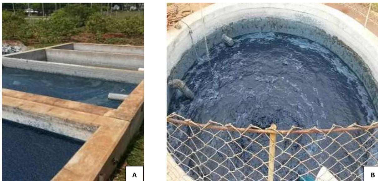
**Figura 6.** Leito de secagem de Lodo (A), Tanque de tanque flotação com lodo na superfície (B).
